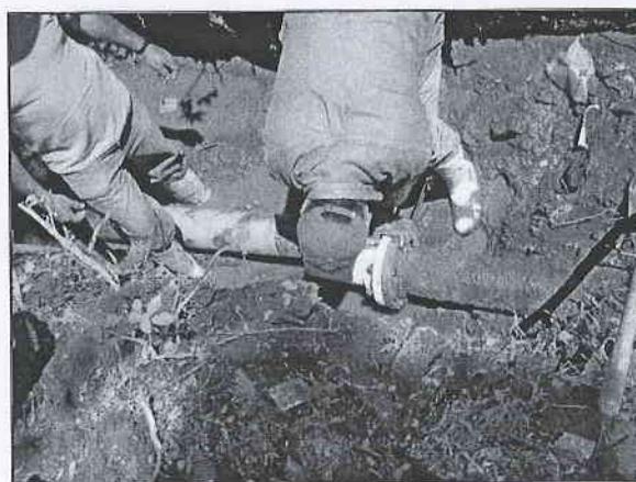
REPARACION DE FUGA, CAMBIANDO EXTREMIDAD PVC DE 8" EN EL CRUCE DEL ARROYO, SALIDA A AYUQUILA
