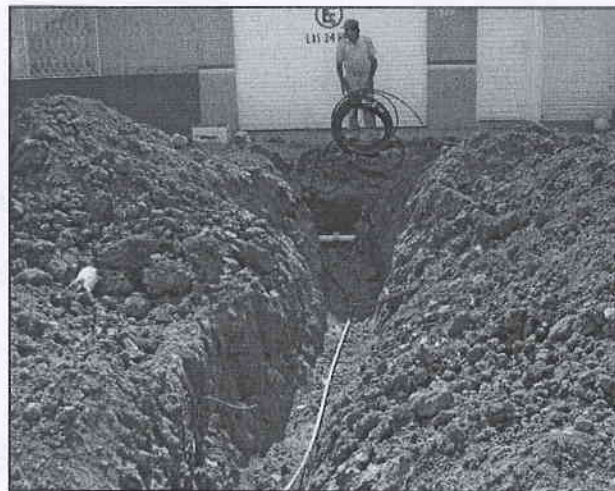
INSTALACION DE TOMA DE AGUA, INSTALACIÓN DOMICILIARIA
